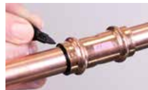
7b. In alternativa, inserire il tubo fino alla battuta e marcare il riferimento
