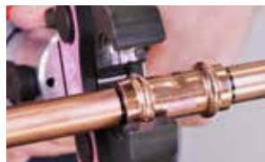
9. Allineare le ganasce perpendicolarmente con il raccordo
