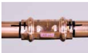
11. Identificazione della giunzione completata
