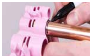
7a. Contrassegnare la profondità di inserimento sul tubo utilizzando l'apposita dima di riscontro
