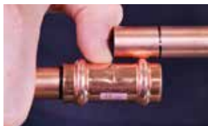
7b. Verifica della profondità di inserimento
