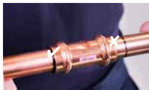
8. Inserire il tubo nel raccordo, assicurandosi che sia completamente in battuta prima di procedere alla pressatura
